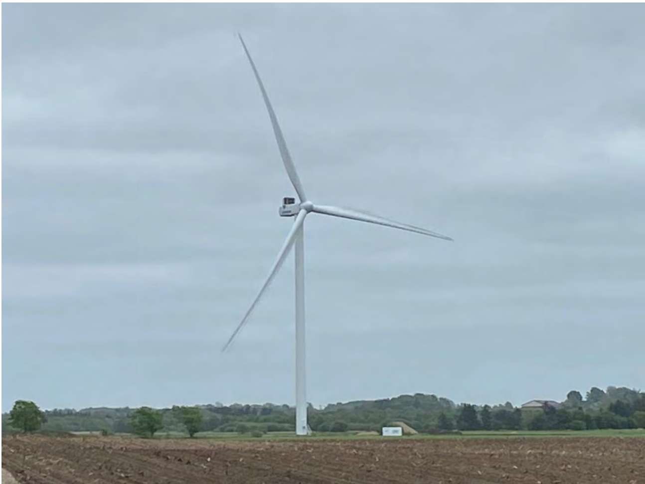
Foto: Vestas V-136 vindmølle med en totalhøjde på 150 m.
