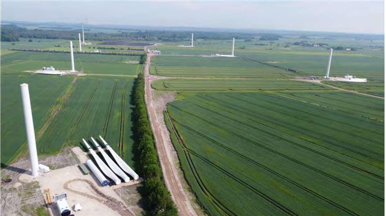
Foto: Eksempel på anlægsarbejde ved opstilling af Vestas vindmøller ved Veddum Kær.
