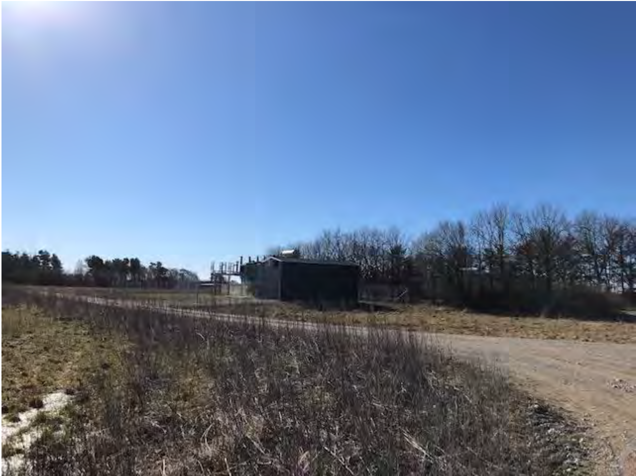
Foto: Eksempel på central transformatorstation ved en vindmøllepark.
