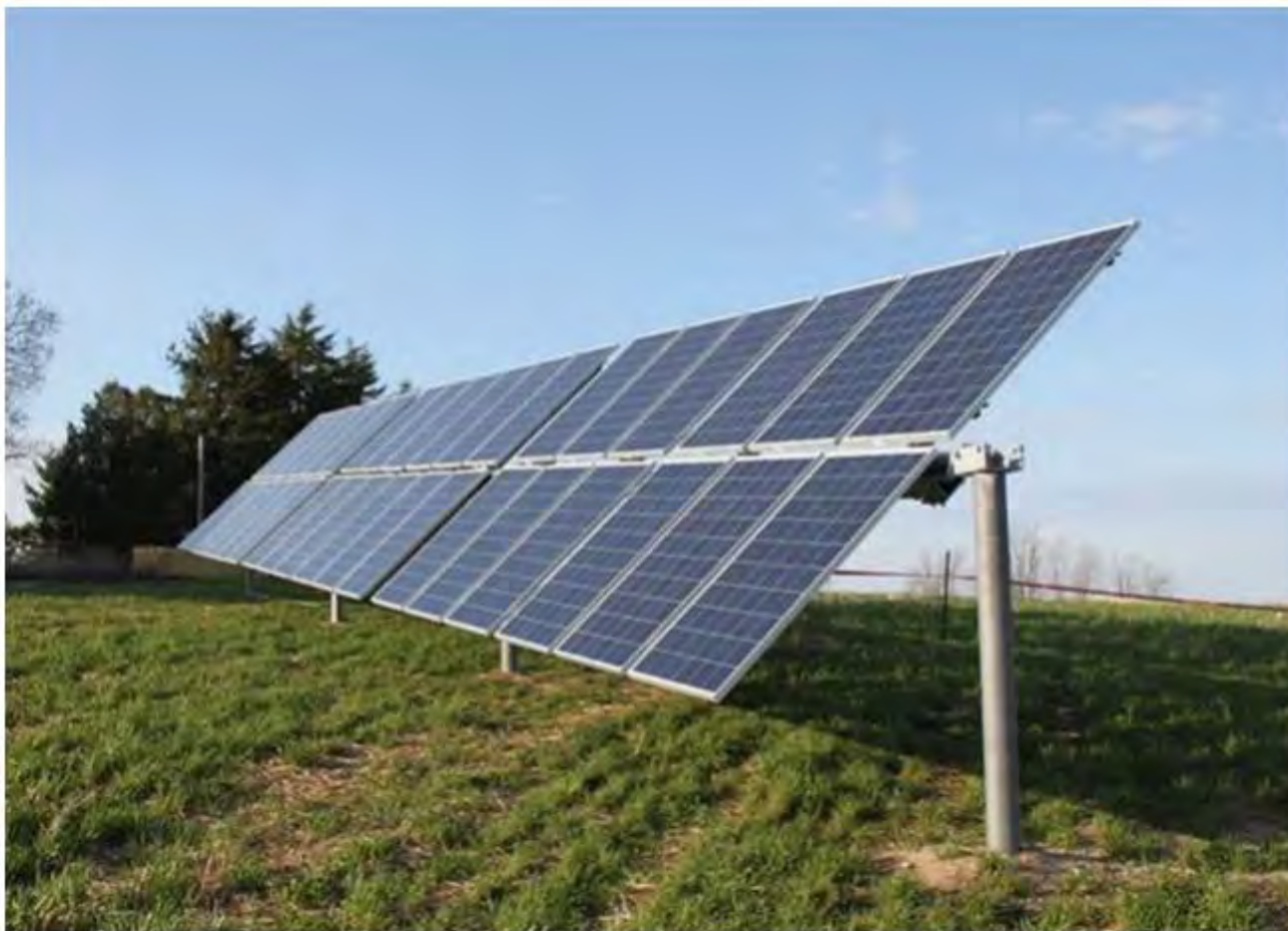
Figur 5.3.3: Solcelleanlæg med trackersystem, som kan bevæge sig om én akse.
