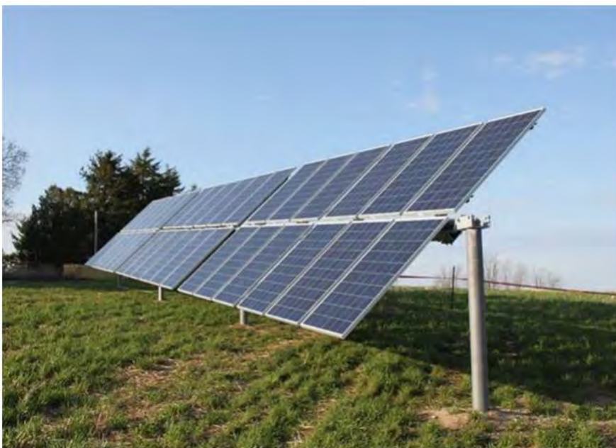
Foto: Eksempel på et solcellepanel med trackersystem, som kan bevæge sig om én akse.
