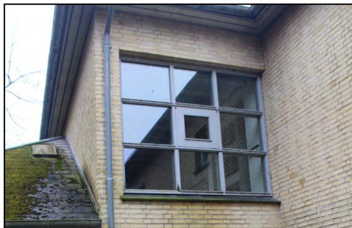
Eksempel på et af de større vinduespartier, som optræder flere steder på bebyggelsen.
