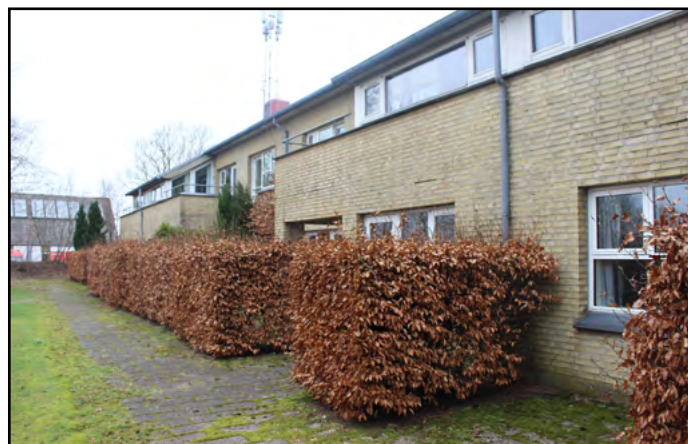
Bøgehækkene omkring terrasserne ved etageboligerne mod nord.
