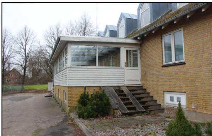
Udestue mod Vongevej, som må fjernes.
