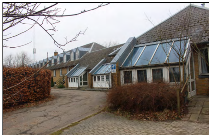
Udestuer ved rækkehusene mod syd, som må fjernes.
