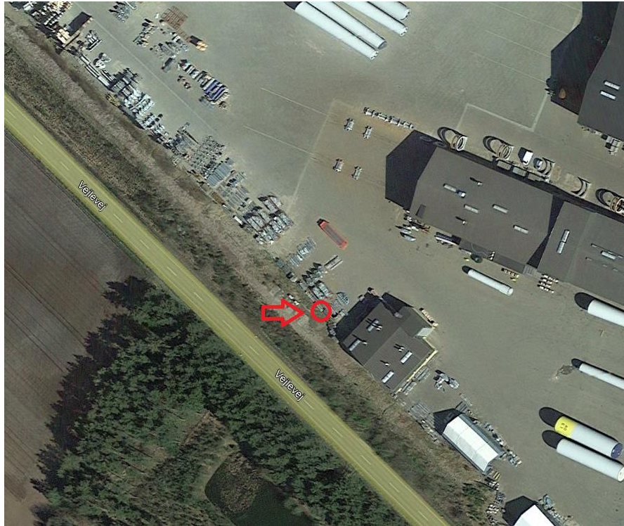
Figur 1: Placering af skorsten, Vejlevej 270
