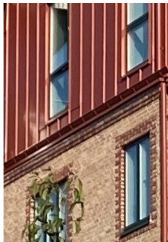
Figur 7 Eksempel på etageopdelt facadebeklædning i teglsten og metalplader med vertikale false.
