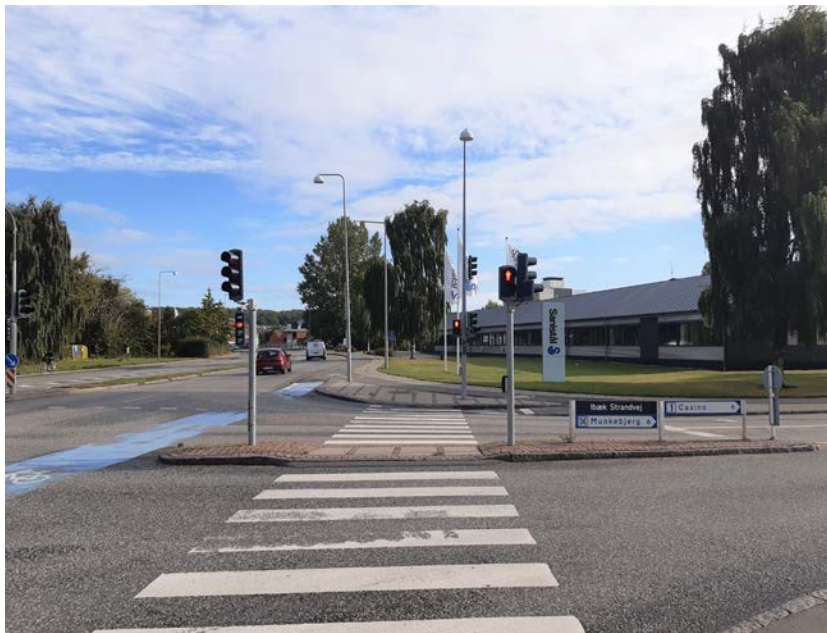
Figur 4. Foto af vejrydset Ibæk Strandvej og Toldbodvej - set fra syd mod nord.
