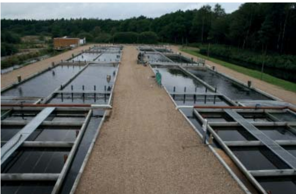
Et nyt anlægs betondamme (raceways) placeret i niveau med omgivelserne. Arbejdsarealerne er befæstet med grus, som giver en markant overgang mellem anlæg og omgivelser.
