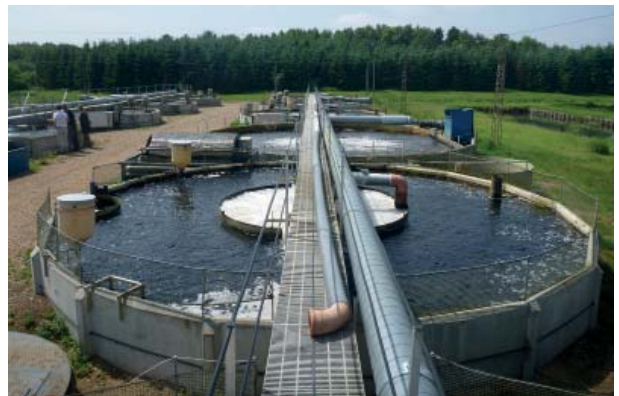
Nyere anlæg med tanke placeret delvist over terrænet fremstår som et markant teknisk anlæg.
