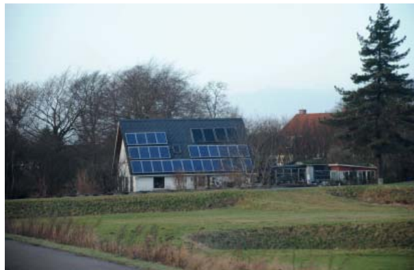
Solceller etableret på bolig i et byområde. Her fremstår solcellerne mere uroligt pga. den opdelte placering og stålindfatning.
